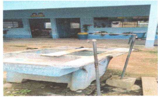
Modulo1: Foto 4 Sustitución de pila
