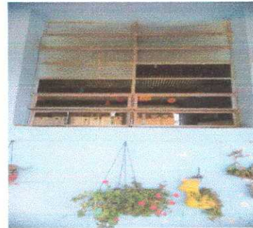
Modulo 2: Foto 6: Modulo 2 Sustitución de vidrios
