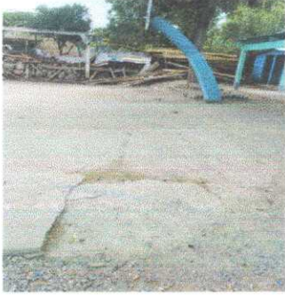
Foto 7: Cancha de Basquet Bol: Reparación de torta de concreto
