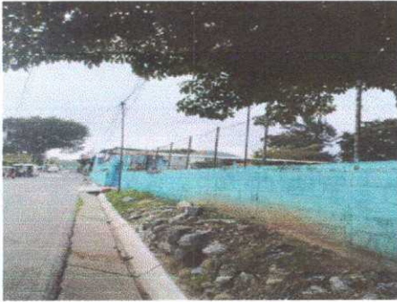
Foto 9: Muro Perimetral: Reparación de muro perimetal con tubo hg y malla galvanizada
