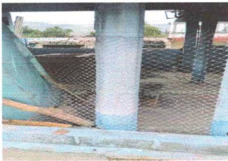
Modulo 1: Foto 3: Sustitución de puerta por puerta tipo reja
