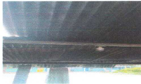
Modulo 1: foto 2 sustición de estructura de soporte.
