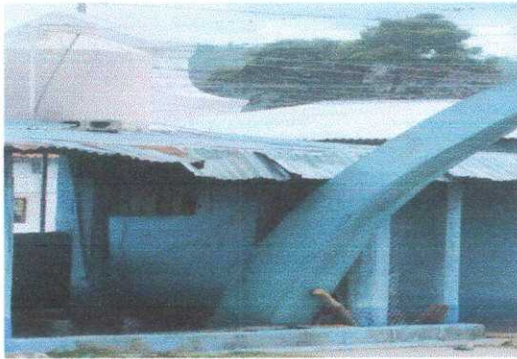
Modulo 1: Foto 1 Sustitución de lamina troquelada en la cocina
