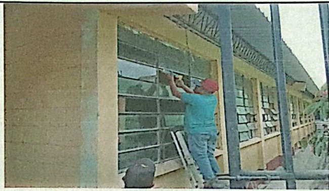
Foto 3: Cambio de vidrios deteriorados
