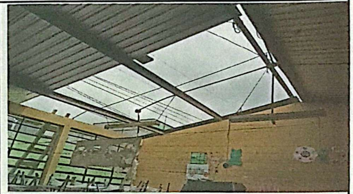
Foto 2: Instalacion lamina troquelada calibre 26
