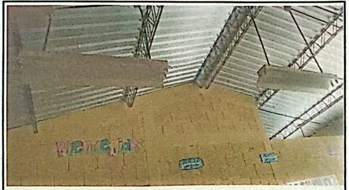
Foto 4: Sustitución e instalación de lamparas
