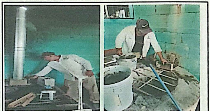
Foto 6: Instalación de chimeneas y parrillas
