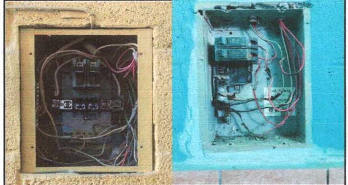
Foto 4: MODULO 1 Sustitución de tableros de flipones
