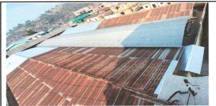
Foto 5: Modulo 2 Sustitución de lamina por lamina troquelada calibre 26
