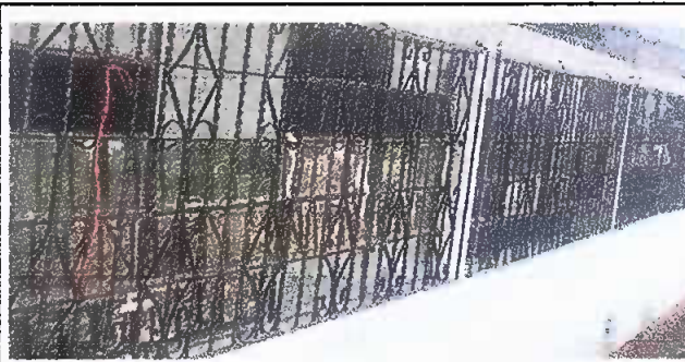
Foto 4: Modulo 2: Suministro e instalación de balcones
