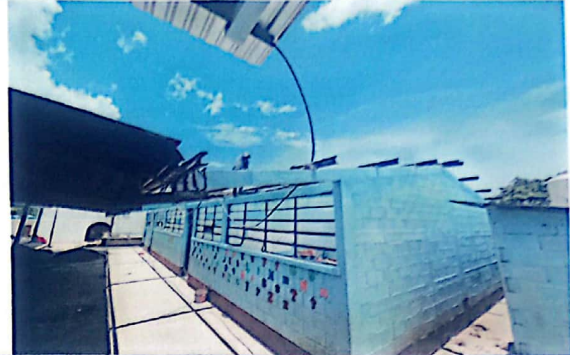
Foto 2: Modulo 2: Sustitucion de lámina por lámina troquelada aluzinc calibre 26
