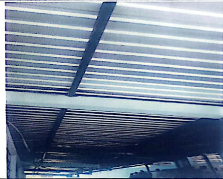
Foto 4: Mantenimeinto estructura metálica, módulo 1, 2 y 3
