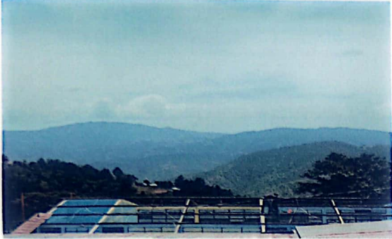
Foto1: Modulo 1: Sustitucion de lámina por lámina troquelada aluzinc calibre 26
