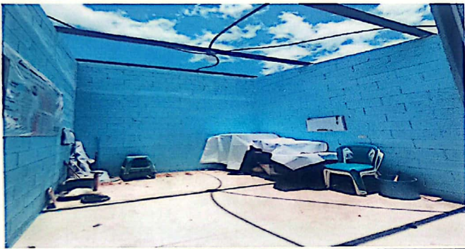
Foto 3: Modulo 3: Sustitucion de lámina por lámina troquelada aluzinc calibre 26
