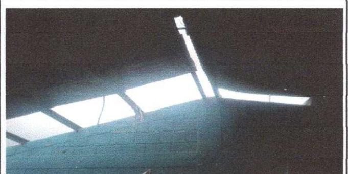
Foto 2: Modulo 2: Sustitucion de lámina por lámina troquelada aluzinc calibre 26
