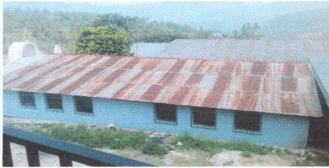
Foto 1: Modulo 1: Sustitucion de lámina por lámina troquelada aluzinc calibre 26
