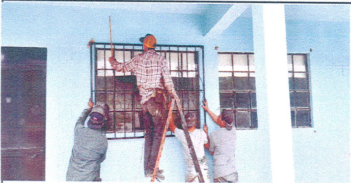
Módulo 3: Sustitución e instalación de balcones
