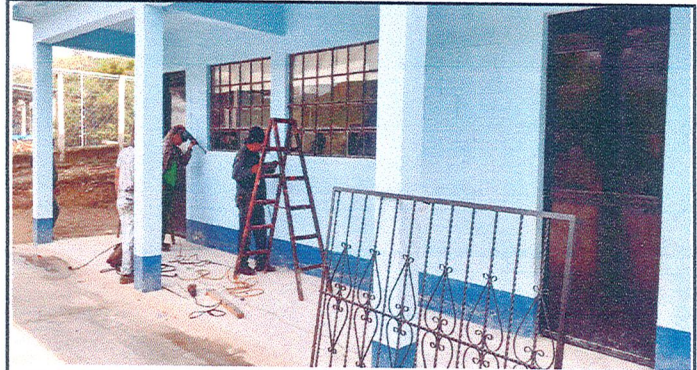
Módulo 1: Suministro e instalación de balcones
