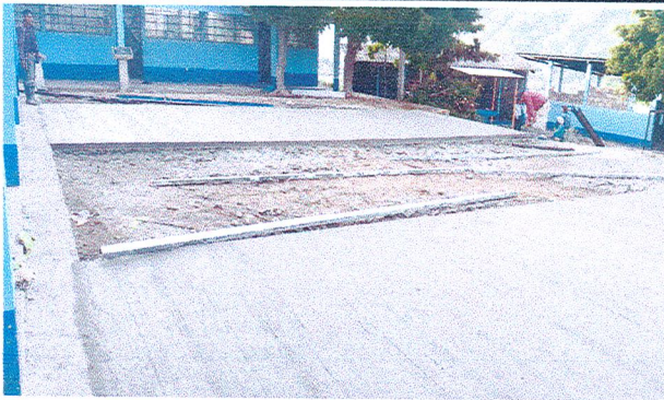
Reparación de plancha de torta de concreto de patio
