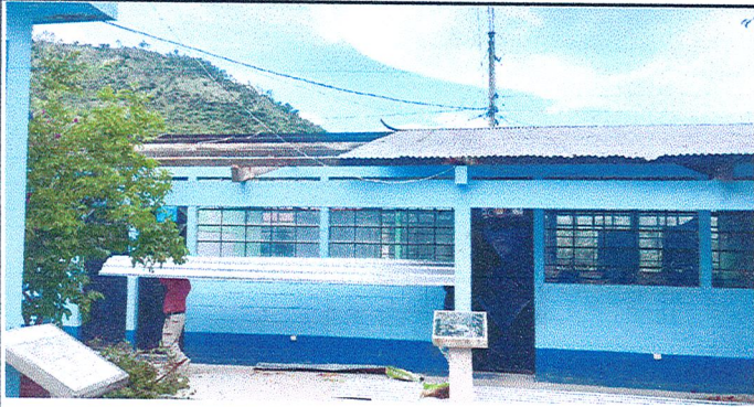
Módulo 1: Sustitución de lámina por lámina troquelada alucin calibre 26
