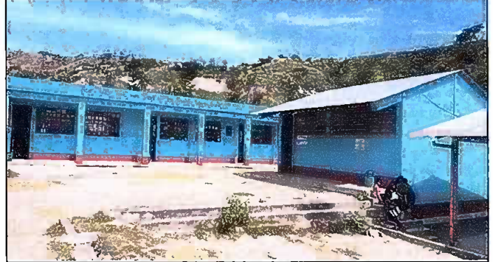
Foto 8: Modulo 1 Pintura en muro exteriores e interiores.
