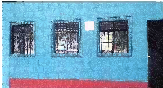
Foto 2: Modulo 1 Reparación de ventanas e instalaciones de balcones.
