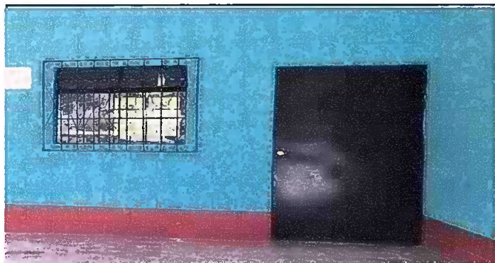
Foto 3: Modulo 1. Sustitución de las puertas.
