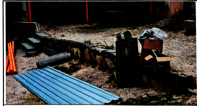
Foto 6 Módulo 1: Cambio de plancha
