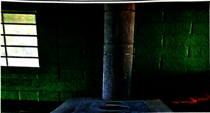
Foto 7 Módulo 1: Cambio de chimenea de metal por uno de concreto
