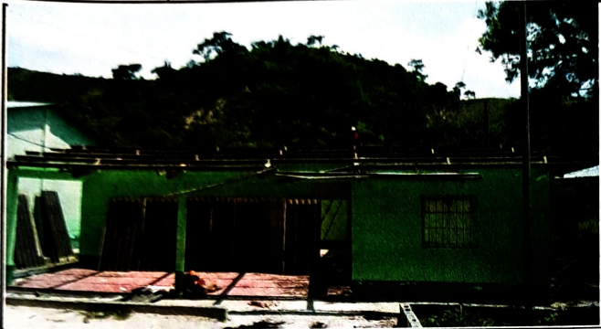
Foto 1 Módulo 1: Sustrucción de lamina de duralita por lámina troquelada, costanera y canaletas fluviales
