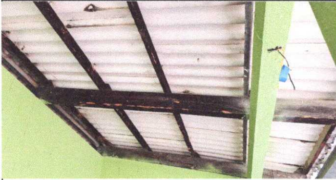
Foto 1 Módulo 1: Sustitución de lamina de duralita por lámina troquelada, costanera y canaletas fluviales
