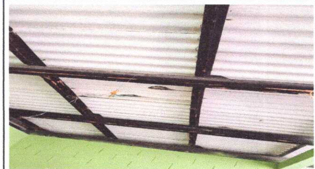
Foto 4 Módulo 1: Suministro e instalación de energía eléctrica
