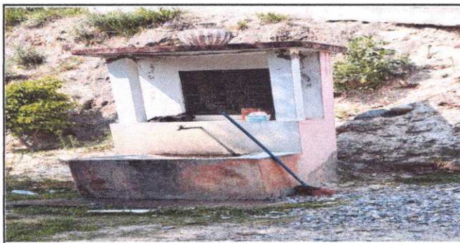
Foto 5 Módulo 1: Sustitución de un lavamano por una pila de dos lavaderos
