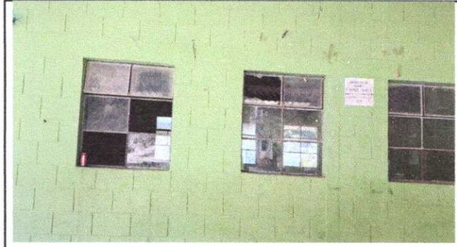
Foto 2 Módulo 1: Reparación de ventanas de metal y instalacion de balcones
