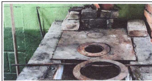
Foto 6 Módulo 1: Cambio de plancha
