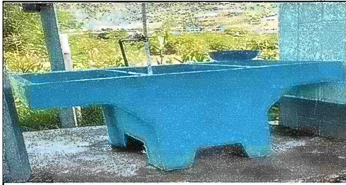
Foto1: sustitución de pila con dos lavaderos
