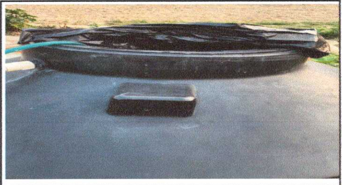
Foto 4: modulo I: cambio e instalación de deposito de agua
