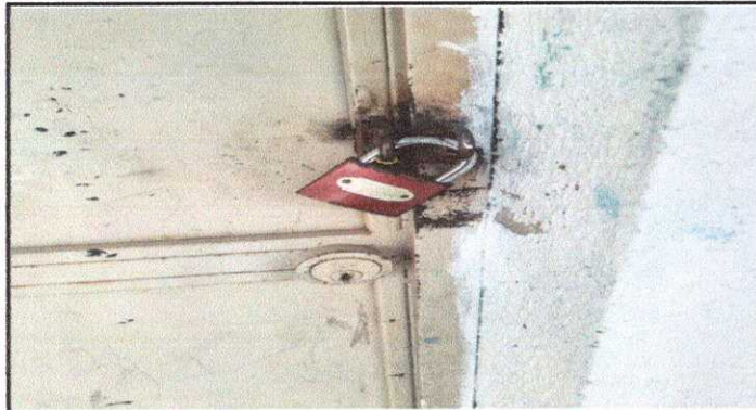
Foto 3: MODULO I; Sustitución de chapas de las puertas
