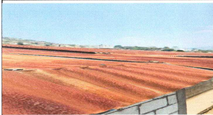
Foto1: Módulo 1; Sustitución de lámina por lámina troquelada
