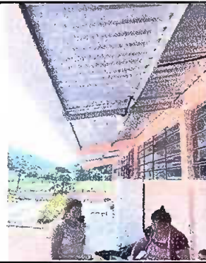
Foto 28: Modulo 3. Sustitución de lámina, por lámina troquelada aluzinc calibre 26
