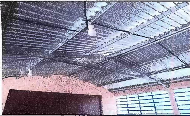
Foto 27 : Modulo 3. Instalación de unidades de luz ( Incluye interruptor, ducto y cable eléctrico)
