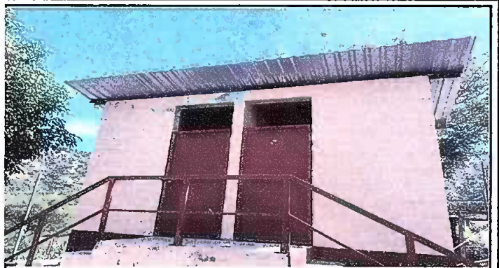
Foto 8 : Modulo 1. Mantenimiento de la baranda
