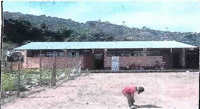
Foto 3: Modulo 2. Instalación de lámina troquelada aluzinc calibre 26
