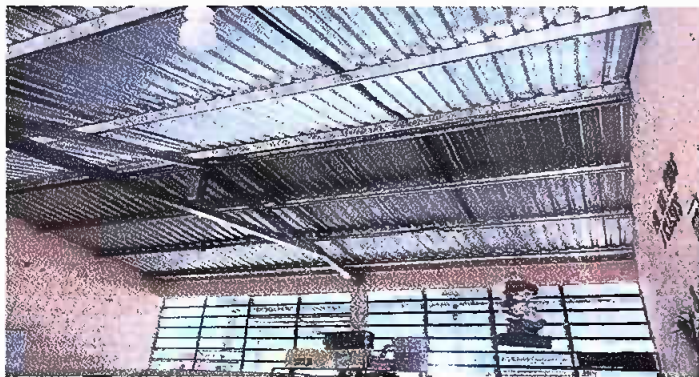
Foto 18. Modulo 3. Instalación lámina troquelada aluzinc calibre 26
