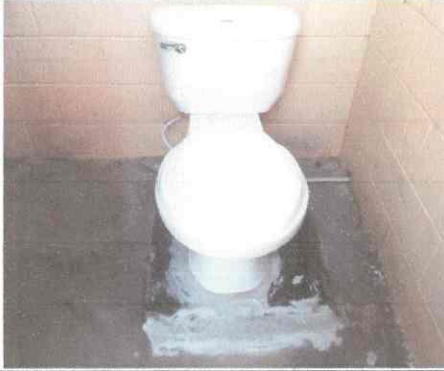
Foto1: sustitución de sanitario
