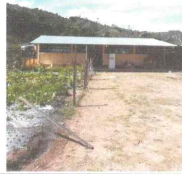
Foto 2: instalación de lámina troquelada
