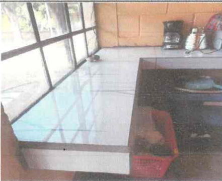
Foto 5: instalación de cerámico en cocina
