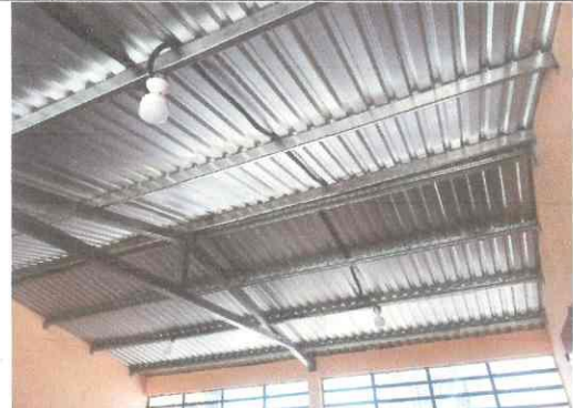
Foto 4: instalación de focos LEED
