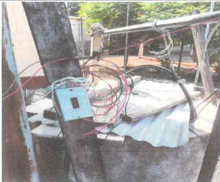
Foto 3: instalación de bomba sumergible
