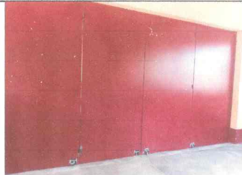
Foto 6: mantenimiento a portón
