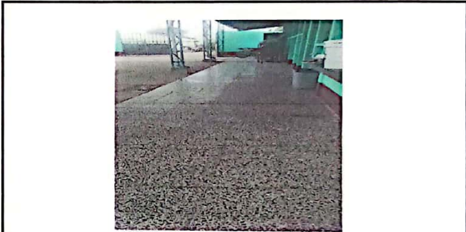
Foto 4: Instalación de piso de granito.
