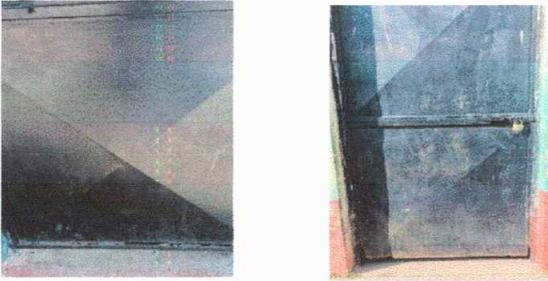
**Foto 4 : mantenimiento a estructura(lijado, cambio de tubo, cepillado, sujecion, aplicacion de pintura) y sustitucion de unas puertas**
