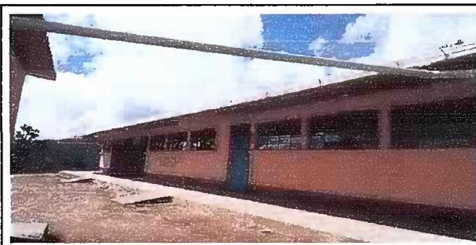
Foto 6: Canal de PVC Yy bajada de agua pluvial
