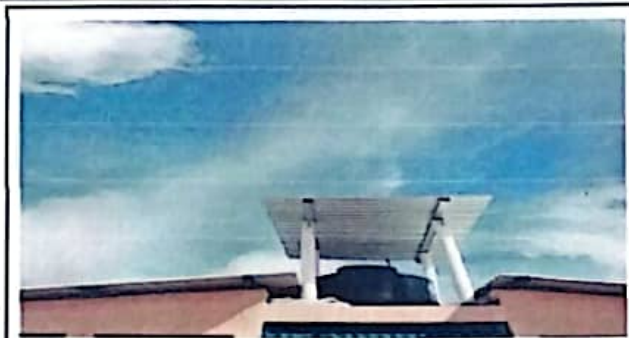
Foto 7: Entechado del depósito de agua
