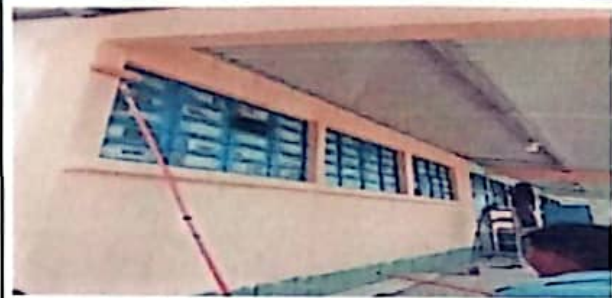
Foto 2: Aplicación de pintura en paredes interiores y exteriores
