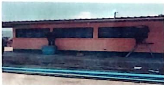
Foto 3: Cambio de vidrios
