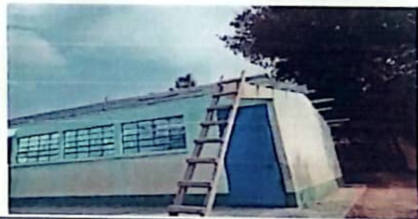
Foto 4: Instalación de estructura de soporte de metal
