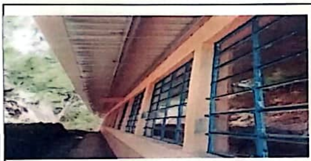
Foto 9: Mantenimiento a estructura de metal de ventana
