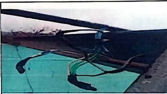
Foto 10: Cambio e instalación eléctrica
