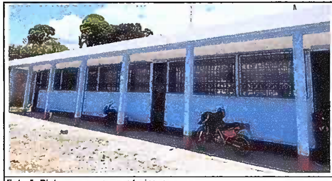
Foto 5: Pinturas en muros exteriores
