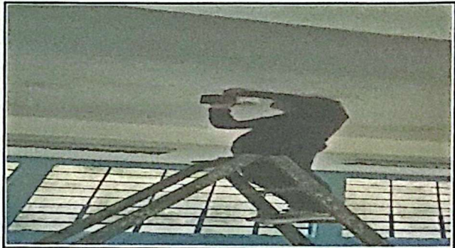
Foto 2: Instalación de unidades de luz (cableado, focos)
