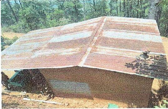
Foto 1: Modulo 1: Sustitución de lamina troquelada
