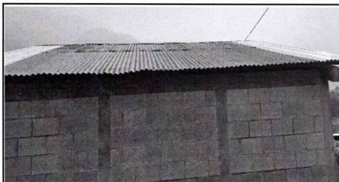
Foto 3 Modulo 2 Sustitución de Lamina por lamina troquelada
