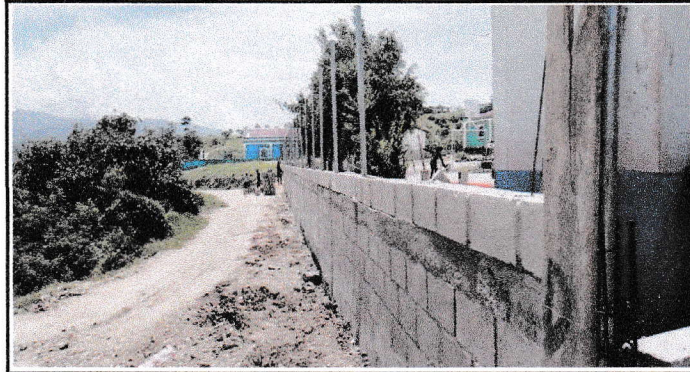
Foto 2: Reparación de muro perimetral de bloques con tubo de hierro y malla galvanizada, soleras intermedias y columnas.
