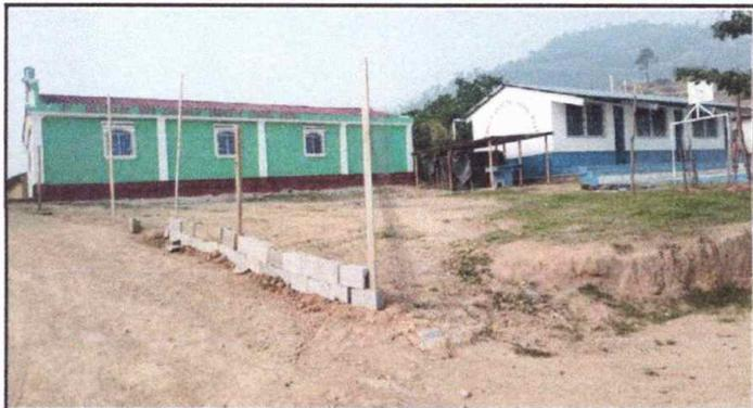
Foto 2: Reparación de muro perimetral de blok con tubo hg y malla galvanizada, soleras intermedias y columnas.
