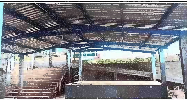
Foto 5: Modulo 5: techado instalado.
