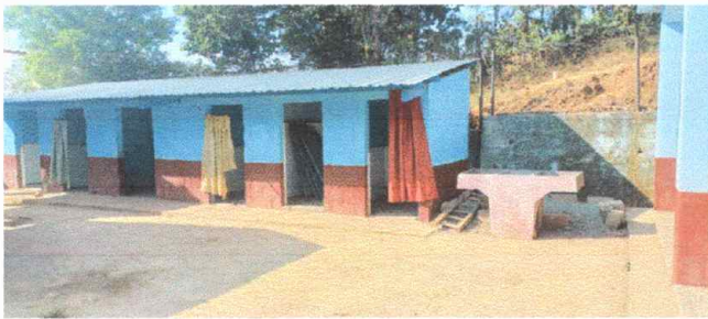
Foto 3: Modulo 3: repación de las puertas de los sanitarios.
