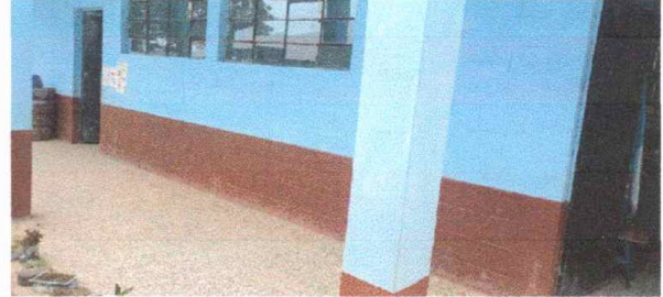
Foto 2: Modulo 1 y 2: suministro de balcones.
