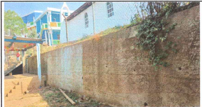
Foto 6: repación de muro de contención.
