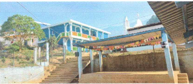
Foto 5: Modulo 5: reparación del techado.
