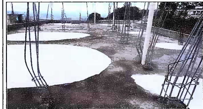
Foto 3: IMPERMEABILIZACIÓN DE LOZA. Terraza impermeabilizada
