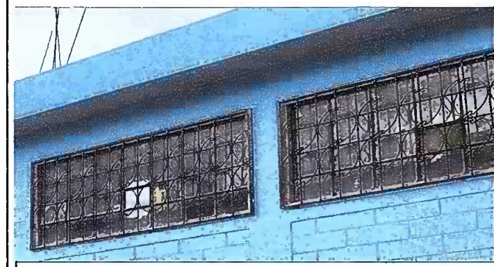
Foto 5: MODULO 1. Balcones instalados
