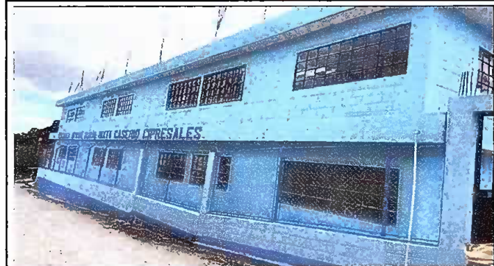
Foto 1: PINTURA GENERAL. Muros exteriores pintados.
