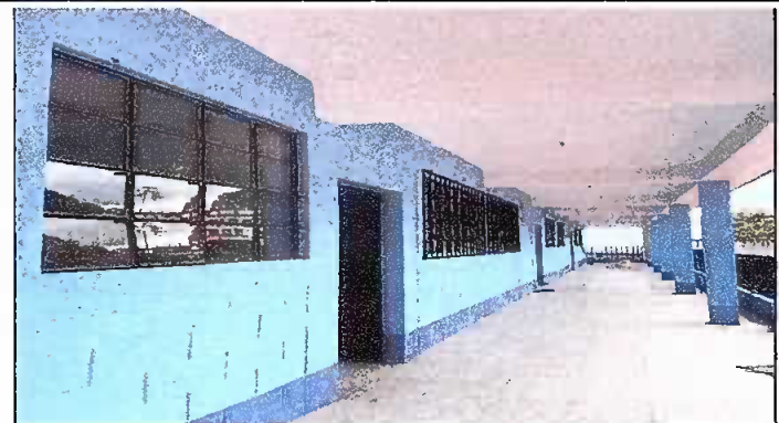
Foto 2: PINTURA GENERAL. Muros interiores pintados
