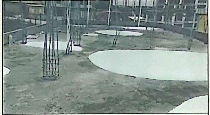
Foto 4: IMPERMEABILIZACIÓN DE LOZA. Impermeabilizando la terraza
