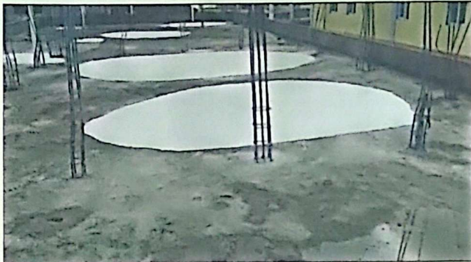
Foto 3: IMPERMEABILIZACIÓN DE LOZA. Impermeabilizando la terraza
