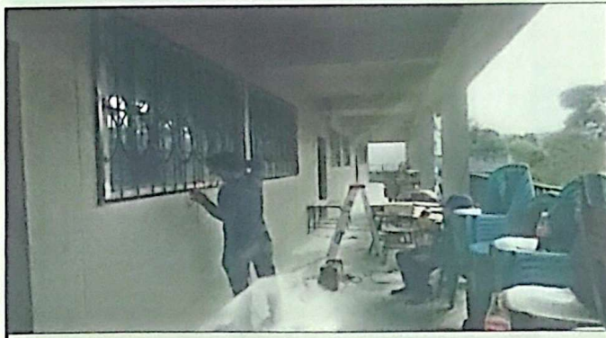
Foto 5: MODULO 1. Instalación de Balcones.
