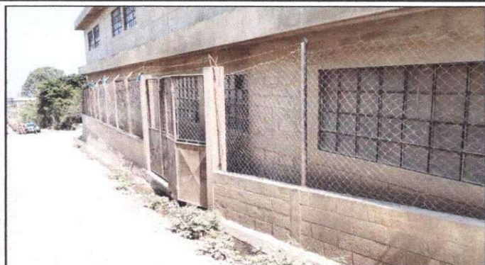
Foto 7: MURO PERIMETRAL. Malla de muro perimetral parte de en frente en mal estado
