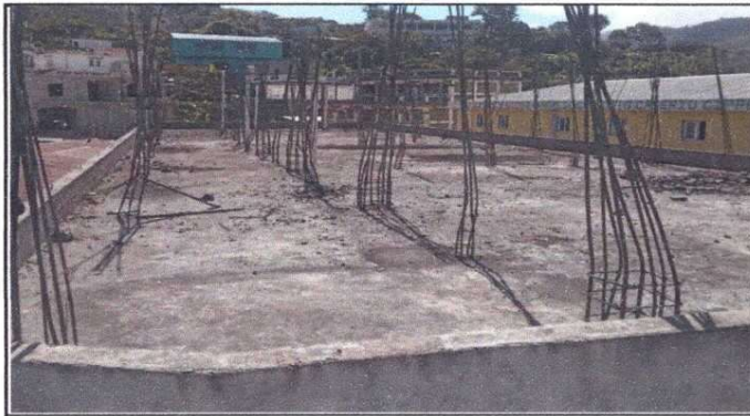
Foto 3: MODULO 1. Impermeabilización de losa
