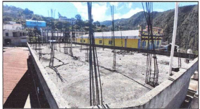
Foto 4: MODULO 1. Impermeabilización de losa
