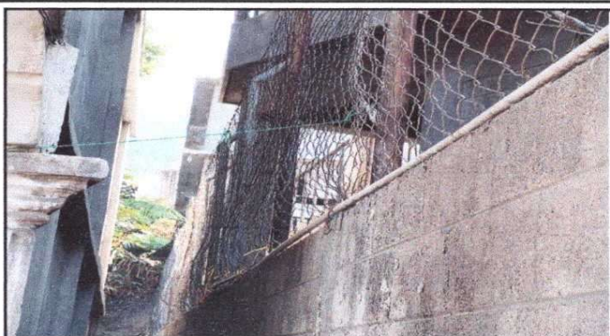
Foto 8: MURO PERIMETRAL. Malla del muro lateral en mal estado.
