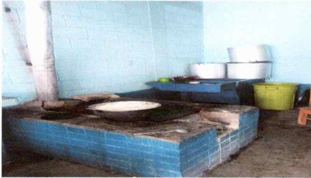
Foto 1: sustitucion de estufa rural (incluye chimenea y plancha de metal)
