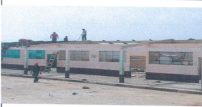
Foto 1 : Desinstalación de lámina y estructura de madera
