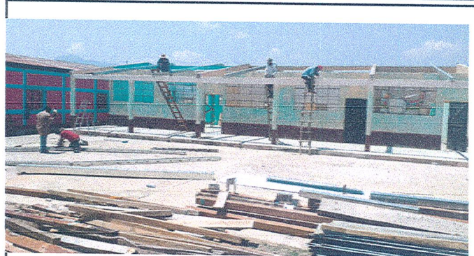
Foto 2: Instalación de estructura de metal
