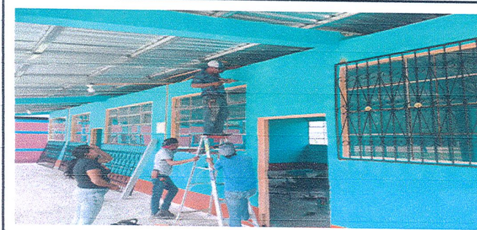
Foto5: Instalación de balcones
