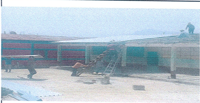
Foto 3: Instalación de lámina
