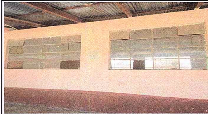
Módulo 1: Pintura general en paredes exteriores e interiores
