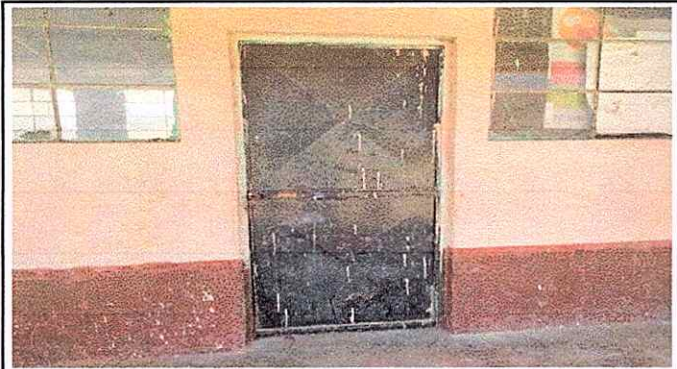
Módulo 1: Sustitución de puerta
