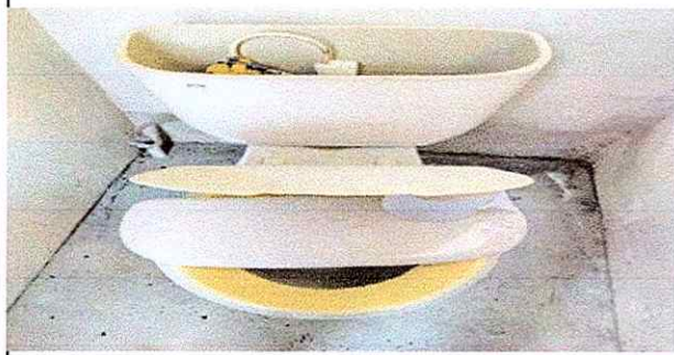
Módulo 3 : Sustitución de accesorios
