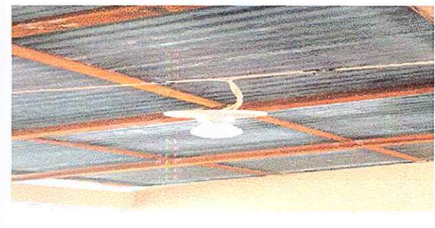
Módulo 1: sustitución plafoneras, focos, cable eléctrico, interruptores, tomacorrientes y ducto + accesorios
