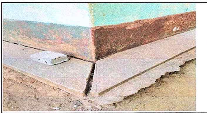
Módulo 1 : Reparación de banqueta de concreto
