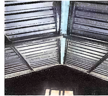
Foto 10, Cocina: colocacion de lamina
