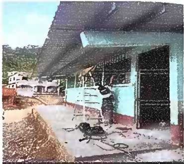
Foto 3, Módulo 1: colocando vidrios
