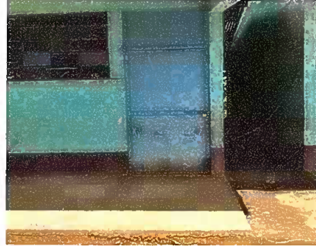
Foto 2, Módulo 1: Sustrucción de puertas de metal
