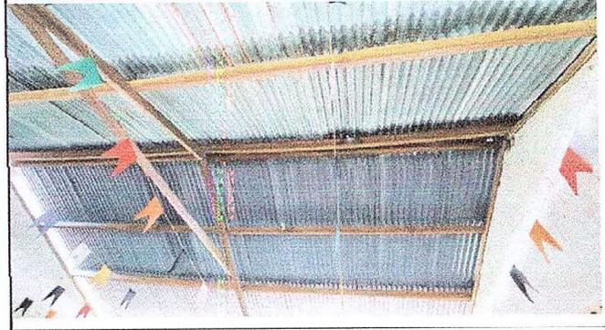
MODULO 1. foto 2 Sustitución de estructura de soporte de madera por metal
