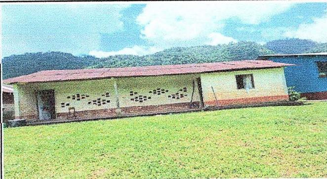
MODULO 1. Foto 1 AULA. Sustitución de láminas esta en mal estado, sustitución de tijera y costaneras de madera a metal
