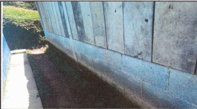
Foto No 1 Cocina. Sústitución de paredes de madera por block
