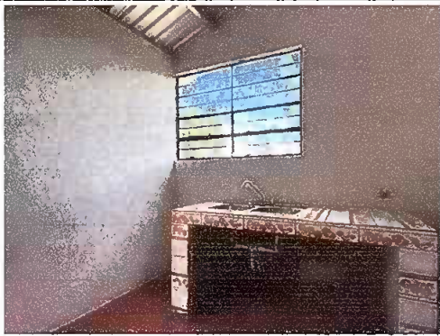
Foto 3: MODULO I Cernido en muro.
