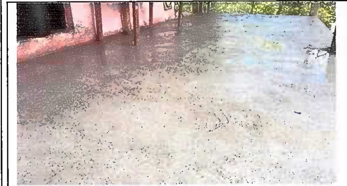
Foto 13: MODULO III Reparación de piso de torta de concreto de corredor.
