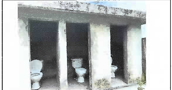
Foto 8: MODULO II Instalación de inodoros y reparación de piso de torta de concreto de sanitarios.
