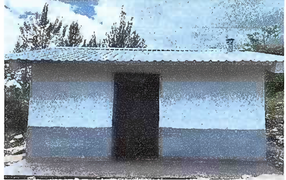
Foto 2: MODULO I Reparación de muro de block.
