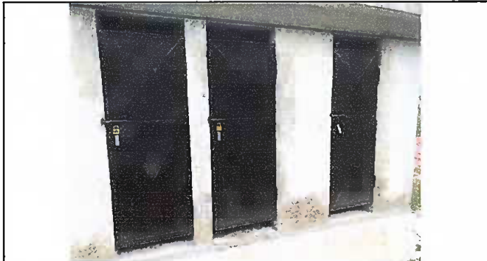
Foto 9: MODULO II Sustrucción de puertas de servicios sanitarios.
