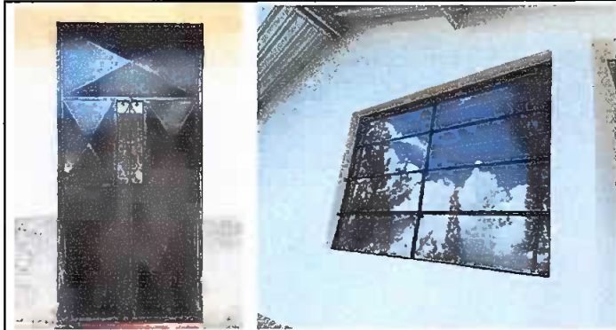
Foto 7: MODULO I Sustrucción de puerta de metal y ventana de madera por metal mas vidrio.
