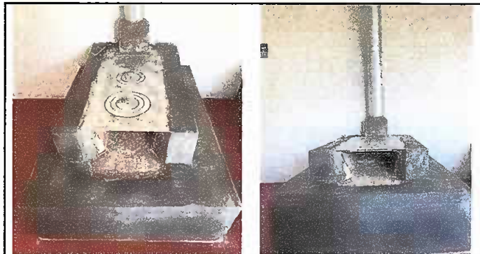
Foto 6: MODULO I Sustrucción de plancha de metal de 3 hornillas, mantenimiento a estufa rural y sustrucción de chimenea de metal.
