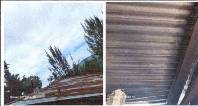
**FOTO 1 MODULO I** Sustitución de lámina troquelada, sustitución de capote de lamina para lamina troquelada y sustitucion de estructura de soporte de madera por metal de la cocina.
