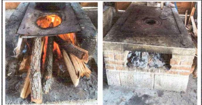
**FOTO 4 MODULO I** Sustitución de planchas de metal de 2 hornillas.
