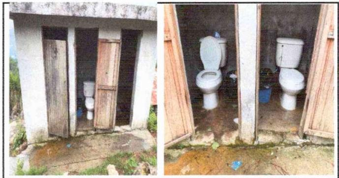
**FOTO 6 MODULO II** Sustitución de inodoro, sustitución de puertas de servicio sanitario y reparación de torta de cemento de concreto.
