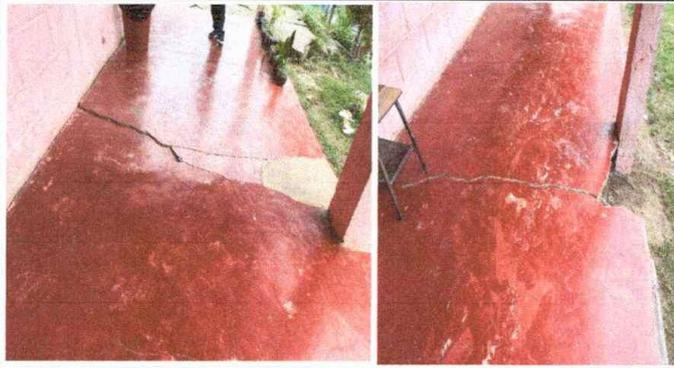
FOTO 7 Modulo III Reparación de piso liquido de corredor.
