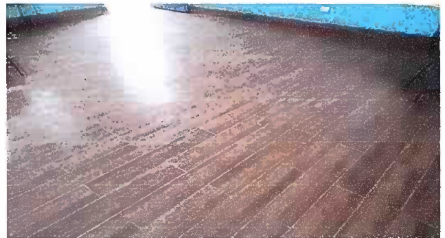
foto. 4. pisos colocados aula numero 4
