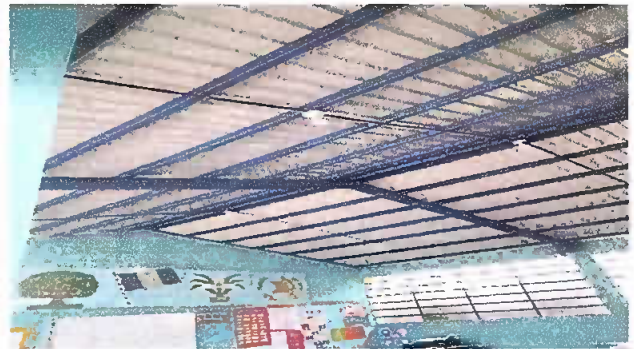
foto 6. laminas colocadas aua numero 1
