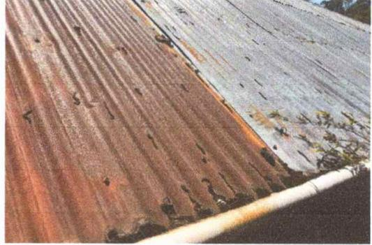
Foto 2, Direccion y Bodega techo y vigas en mal estado
