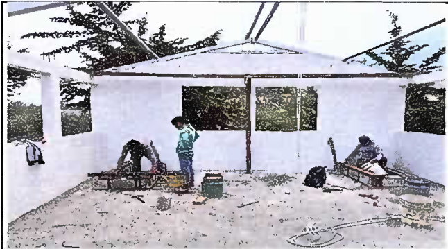
Foto 1: Cambio de estufa (pollo) en mal estado.
