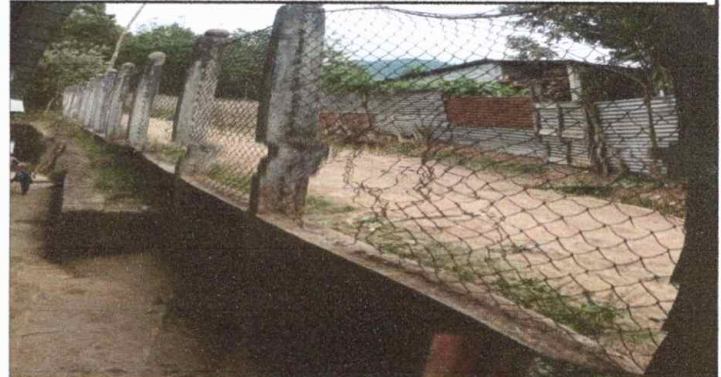
Foto 2: Cambio de malla por muro de block
