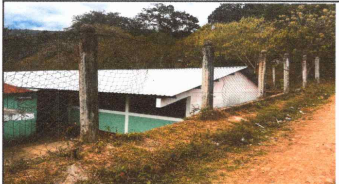
Foto 3: Cambio de malla por muro de block
