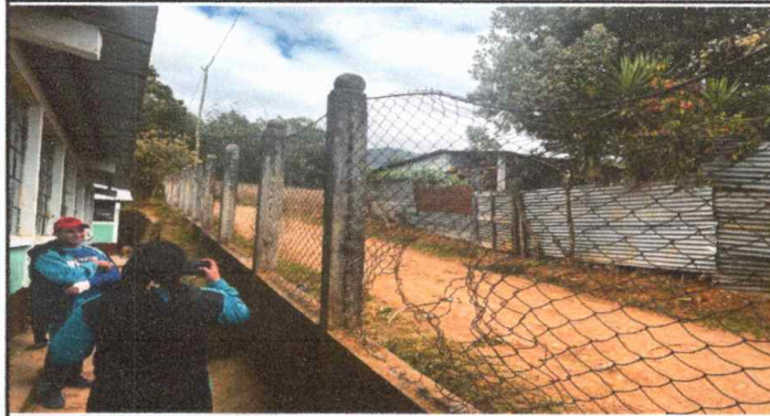
Foto 1: Cambio de malla por muro de block
