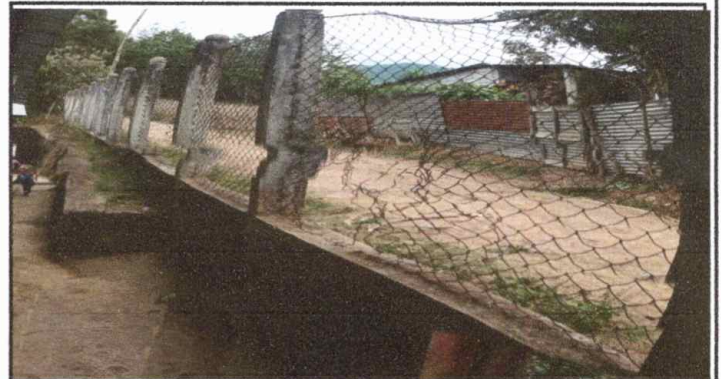
Foto 4: Cambio de malla por muro de block
