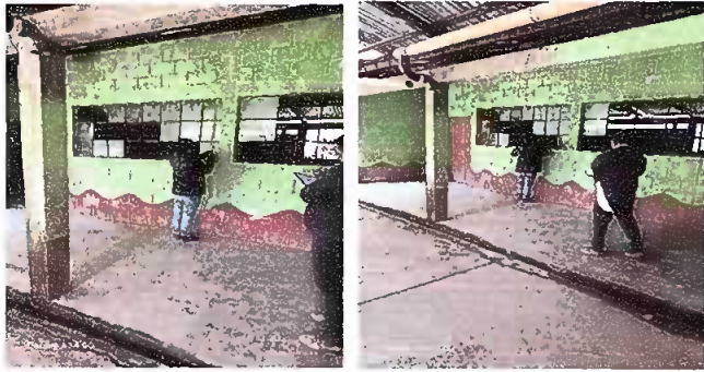
Foto 7: Aula No. 5, cambio de vidrios y balcones al frente y atrás.
