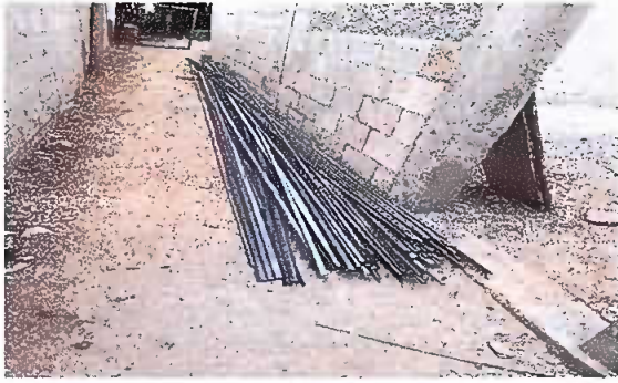
Foto 7: Aula No. 5, cambio de vidrios y balcones al frente y atrás.
