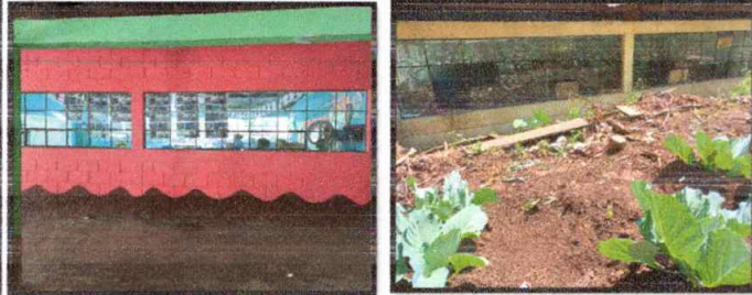
Foto 11: Aula No. 6, balcones y vidrios frente; Foto 12: Aula No. 6, Balcones detrás.
