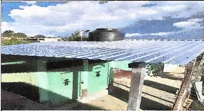
Foto 3: Techo de sanitarios
