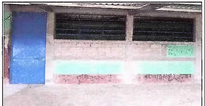
Foto 6: Ventanas y puerta del aula
