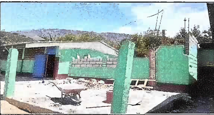
Foto 5: Cambio de techo del corredor
