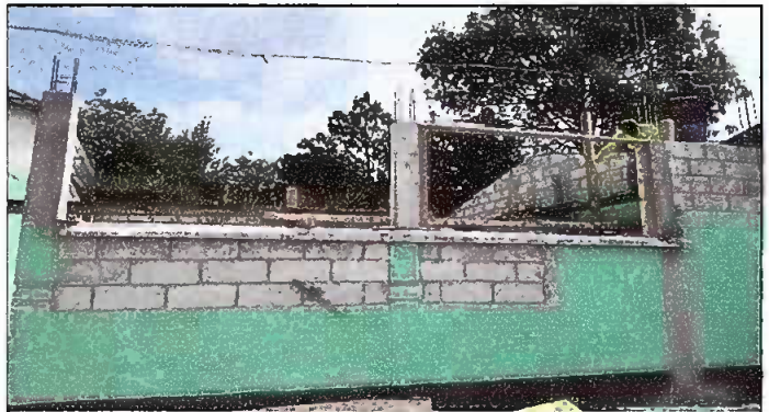
Foto 4: Cambio de ventanas
