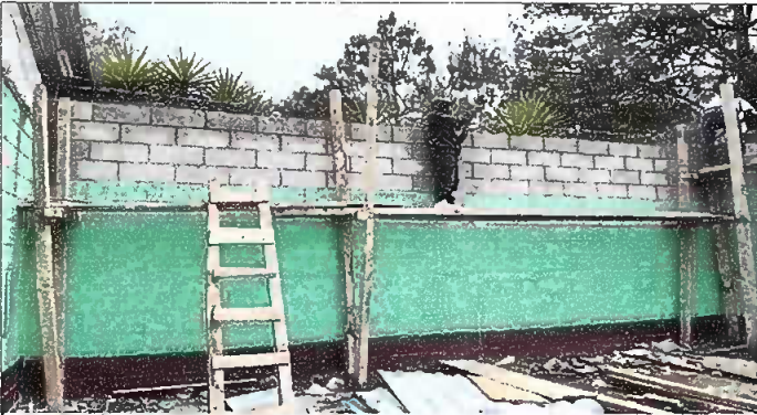
Foto 3: Modulo No. 2 Completación de pared de 4 mts a 6mts
