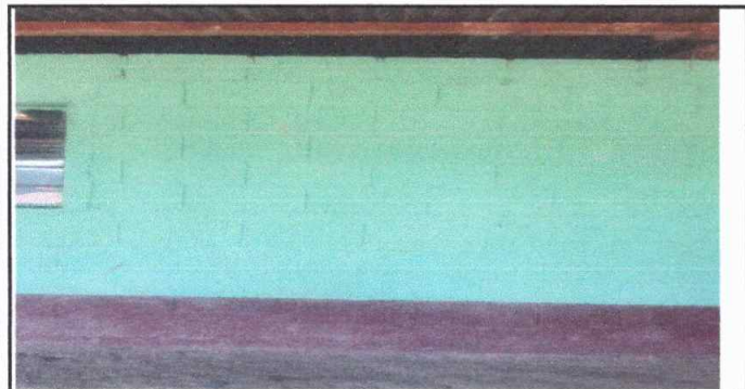
Foto 3: Reparación de muro de block
