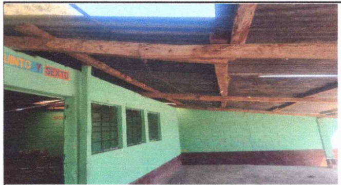
Foto 2: Cambio de techo, laminas y vigas de madera en mal estado del corredor
