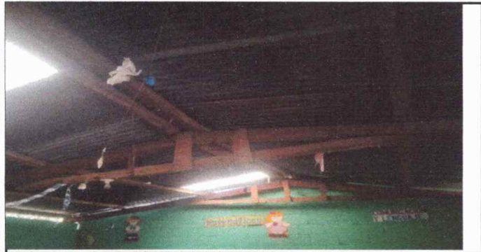
Foto 1: Cambio de techo, laminas y vigas de madera en mal estado
