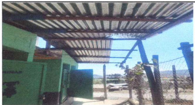
Foto 4: Baños cambio de techo
