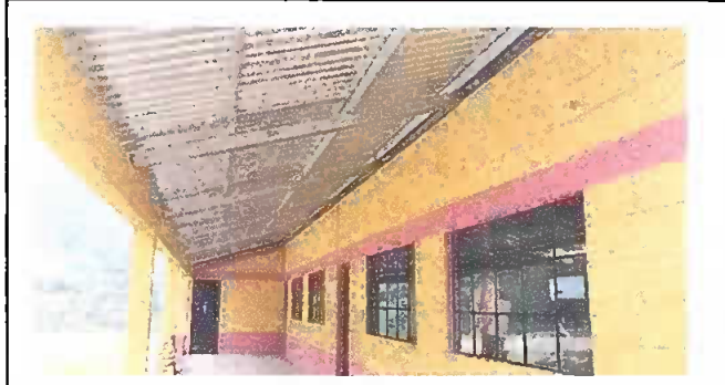
Foto1: Sustitución de ventanas de madera por metal con vidrio
