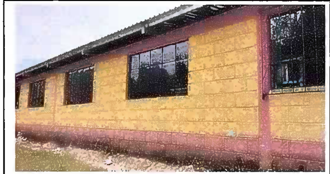
Foto2: Sustitución de ventanas de madera por metal con vidrio
