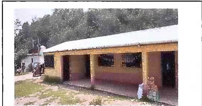
Foto 4: Sustitución de lámina por lámina troquelada
