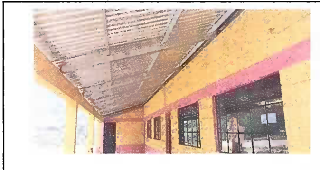
Foto 3: Sustitución de lámina por lámina troquelada y cambio de paraes por costaneras
