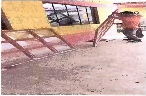
Foto1: Sustitución de ventanas de madera por metal con vidrio
