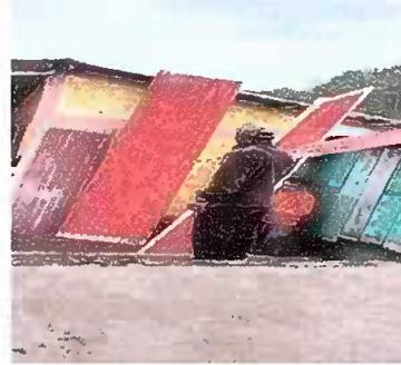
Foto 4: Sustitución de lámina por lámina troquelada
