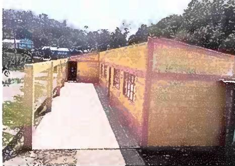
Foto 3: Sustitución de lámina por lámina troquelada y cambio de parales por costaneras
